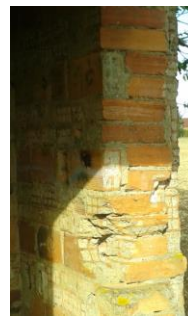
Appareillage en briques
