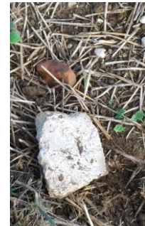
Restes de maçonnerie
